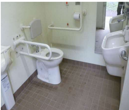
多目的トイレの設置
