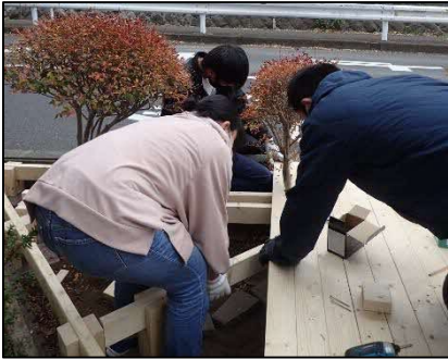
若者運営委員会 エントランスベンチ製作
